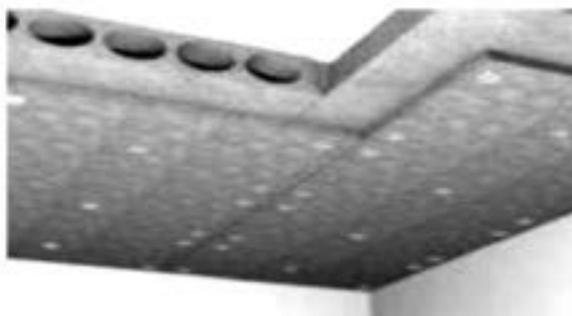
Рисунок – 3.30. Приклад утеплення перекриття зі сторони підвалу
