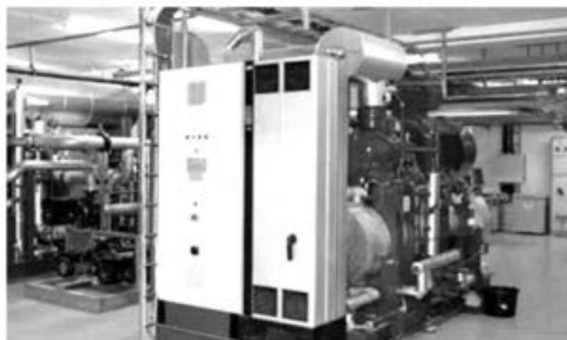
Рисунок 3.18 – Промислова холодильна установка з частотним перетворювачем
